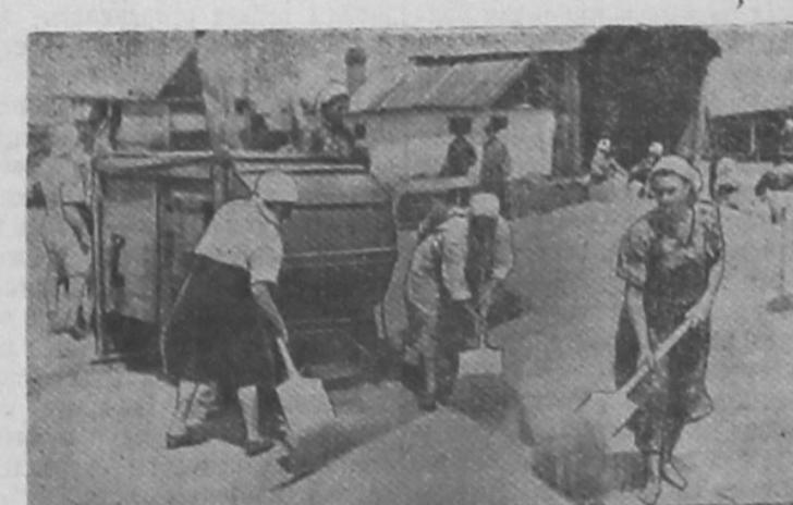
В колхозе «Коммунар» Ворошиловского района оборудован механизированный ток. Большие зерноочистительные машины, веялки, ленточные транспортеры приводятся в движение при помощи электричества. Оборудование тока произвели шефствующие организации города Ворошилова.
